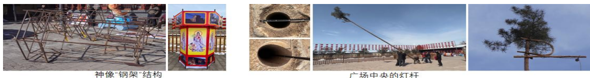
图 3 钢架结构、灯杆 图片来源:作者自摄
