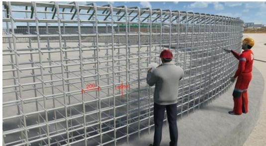
航煤储罐环墙钢筋绑扎可视化交底视频截图
