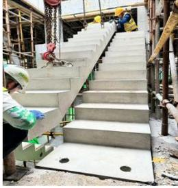
图 3.2.4-2 第二部分吊装落位
