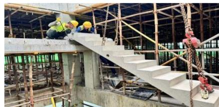
图 3.2.4-1 第一部分吊装落位
