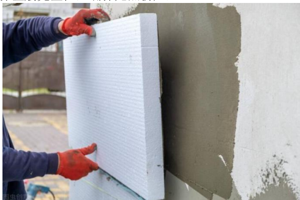
图 1: 外墙保温施工技术示意图
