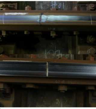
图 3-11 道岔绝缘接头打磨效果
