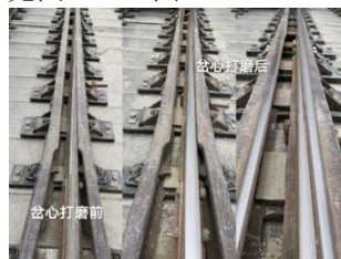
图 3-6 道岔辙岔打磨
