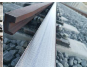
图 3-7 护轨地段打磨
