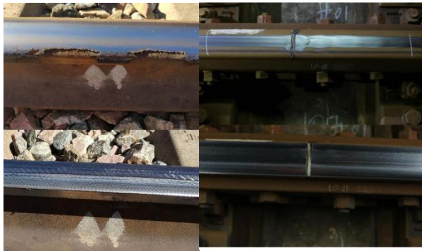
图 3-10 钢轨掉块打磨效果
