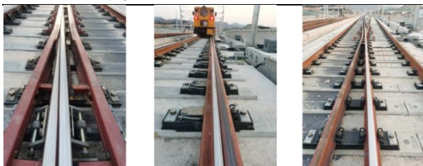
a 道岔心轨 b 道岔尖轨 c 道岔直股
