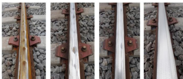
图 3-5 波磨打磨效果
