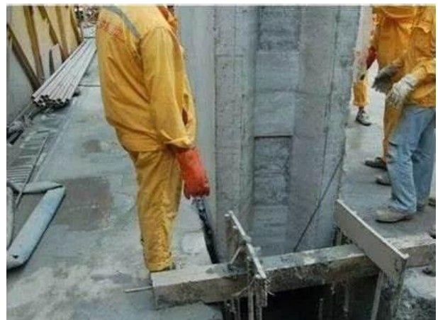
图 1 预制地下连续墙
