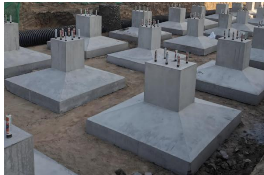
图 1 预制混凝土基座
