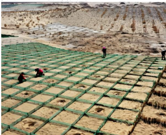
图2 施工现场的防风沙措施
