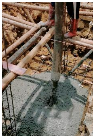
图 2 混凝土浇筑
