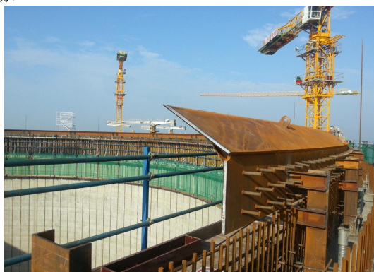
图 3 承压环安装效果
