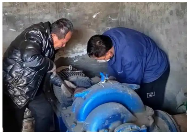
图4 泵站机电设备保养
