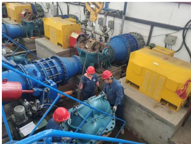
图3 泵站机电设备维修
