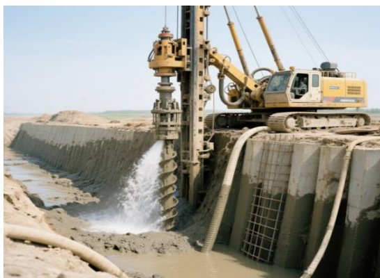
图 2 射水造孔浇筑混凝土防渗墙技术
