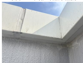
图十二 外墙压顶板内侧胶缝施工实例
