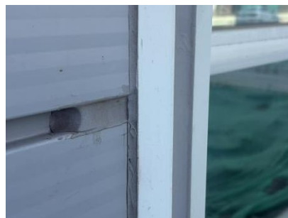
图十七 外墙窗洞口侧面收边施工实例
