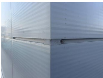
图六 外墙板阳角胶缝施工实例
