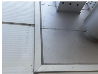
图十九 外墙设备管道洞口侧面收边施工实例
