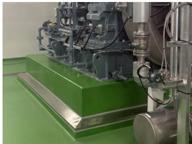
图三十三 设备基础周边防虫封堵（二）
