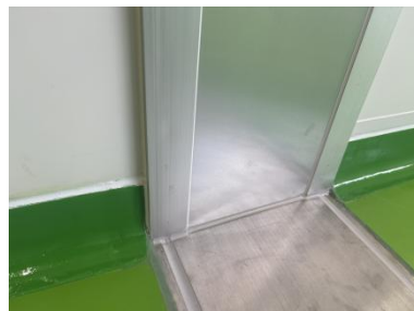
图二十九 连廊伸缩缝地面盖板施工实例
