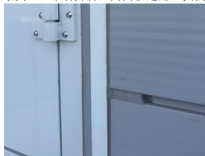
图十八 外墙门洞口侧面收边施工实例
