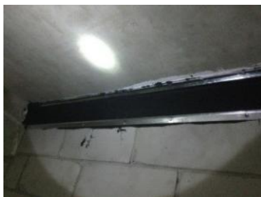
图二十六 砌体通高墙斜砌部分防虫布封堵
