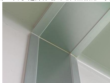
图三十 连廊伸缩缝墙面盖板施工实例
