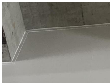
图二十三 通高洁净板顶部封堵施工实例
