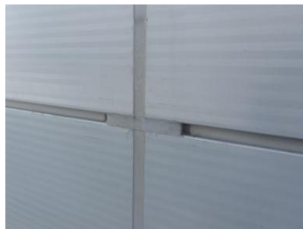
图五 外墙板竖向胶缝施工实例
