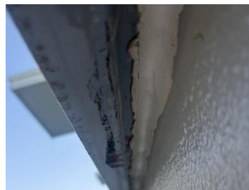
图十 外墙台度下口胶缝施工实例
