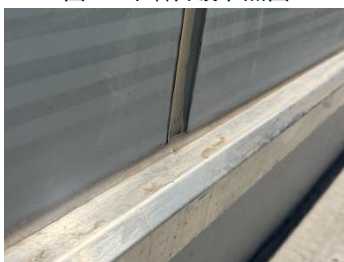
图九 外墙台度上口胶缝施工实例
