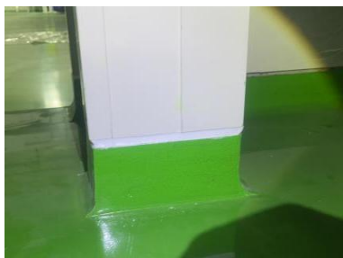
图二十五 洁净板底部导墙施工实例
