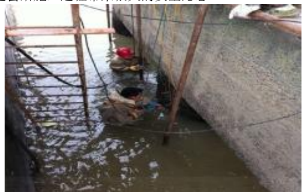
图一, 水利工程施工
