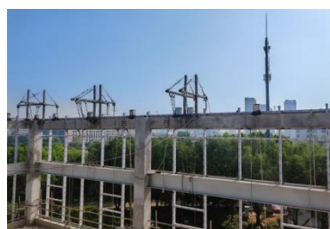
图2 骑马架吊篮图
