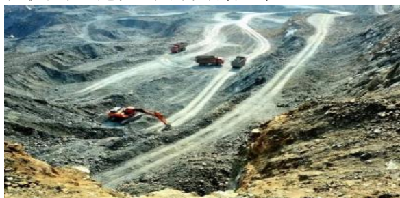
图 1 矿山建设工程
