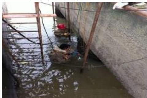
图一，水利工程施工
