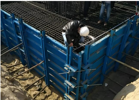
图1 现场模板拆除
