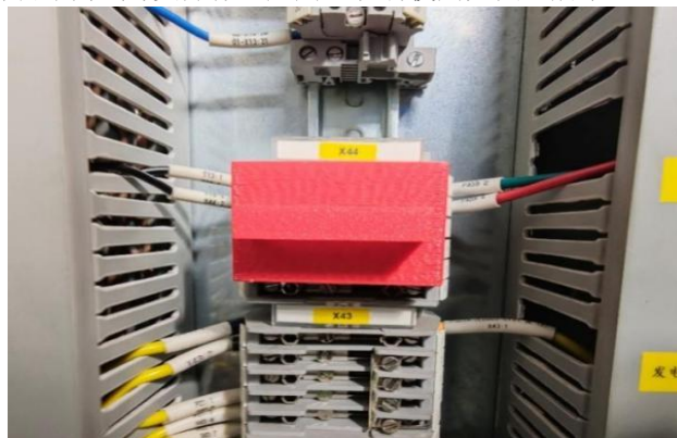
图 3 新型防误碰端子排隔离工具现场应用
