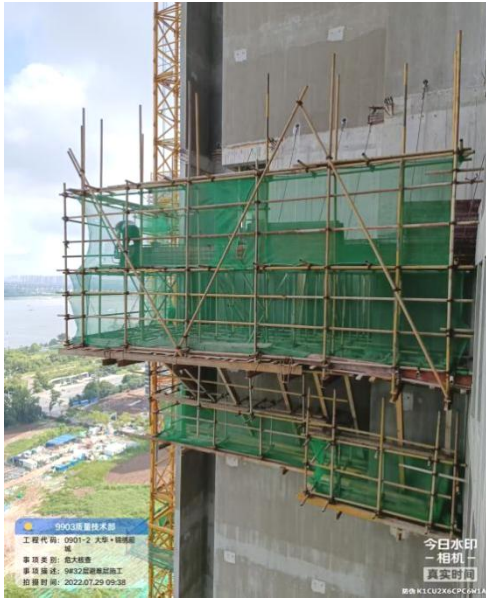
图2 工程施工现场
